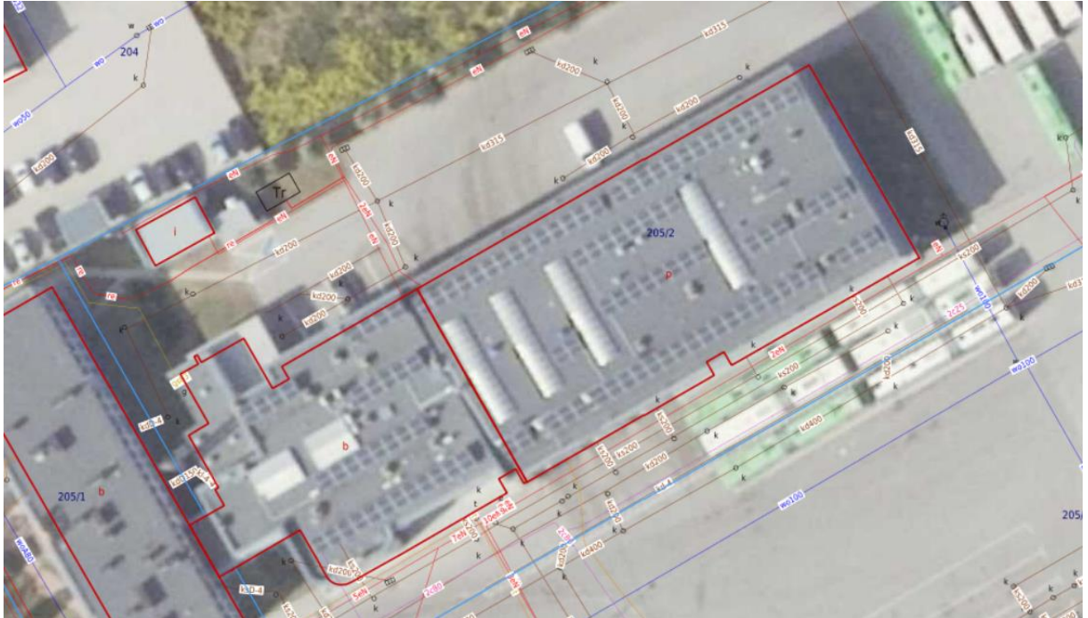
Rys. 1. Widok działki inwestycyjnej.
